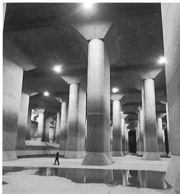
調圧水槽(通称:地下神殿)
