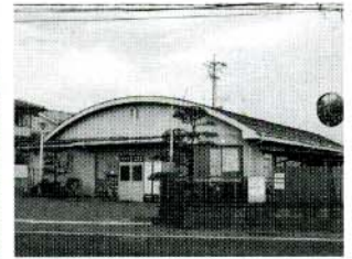
東和田公会堂 （昭和41年築 46年経過）
