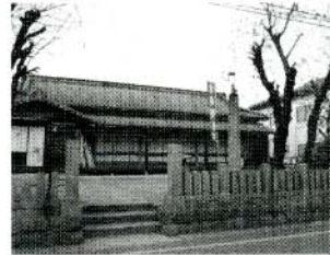
南高田公会堂 （昭和30年築 56年経過）
