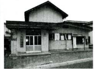
中村公会堂 （昭和50年築 36年経過）
